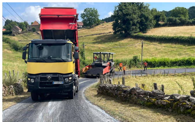
Réfection de chaussée, route du Tillay à Suin.
