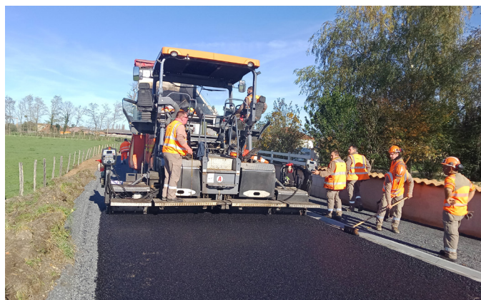
Lors des travaux effectués cet automne route de la Varenne
