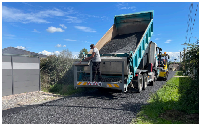
Lors d'un chantier d'enduit (gravillonnage) réalisé cette année à Saint-Aubin
