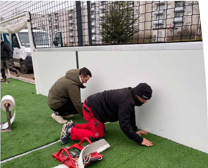
Pose de la moquette du terrain de foot synthétique le 12 decembre 2024
