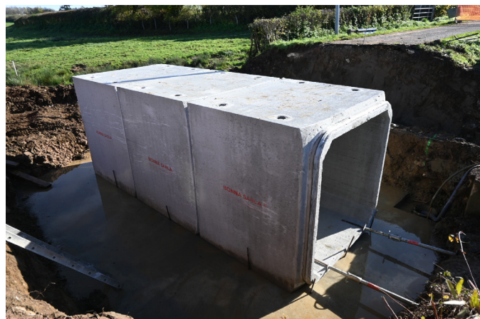
Pendant les travaux de reconstruction de pont, effectués cet automne près du bourg de Mornay
