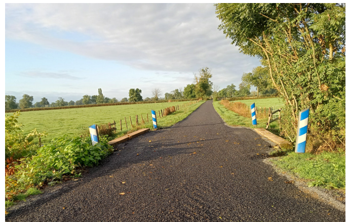
L'un des chantiers de voirie réalisés cette année à L'Hôpital-le-Mercier
