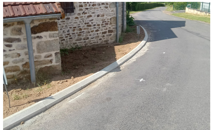
Le chantier de voirie réalisé cette année à Grandvaux
