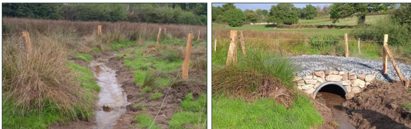
Figure 11. Photos après travaux. A gauche, le lit restauré en fond de vallon et mise en défens. A droite, un passage sous arche créé pour l'exploitation de la parcelle de part et d'autre du ru.
