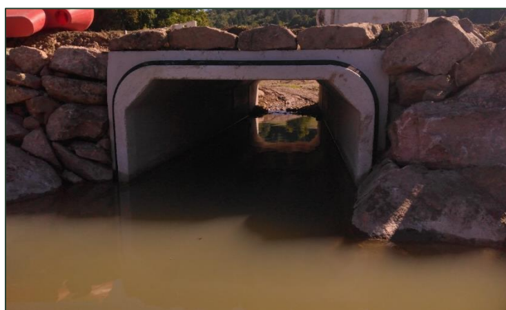
Figure 35. A gauche, l'arrivée des ponceaux. A droite, le ponceau traversant la route, juste après mise en place et avant l'apport d'alluvions (octobre 2025).
