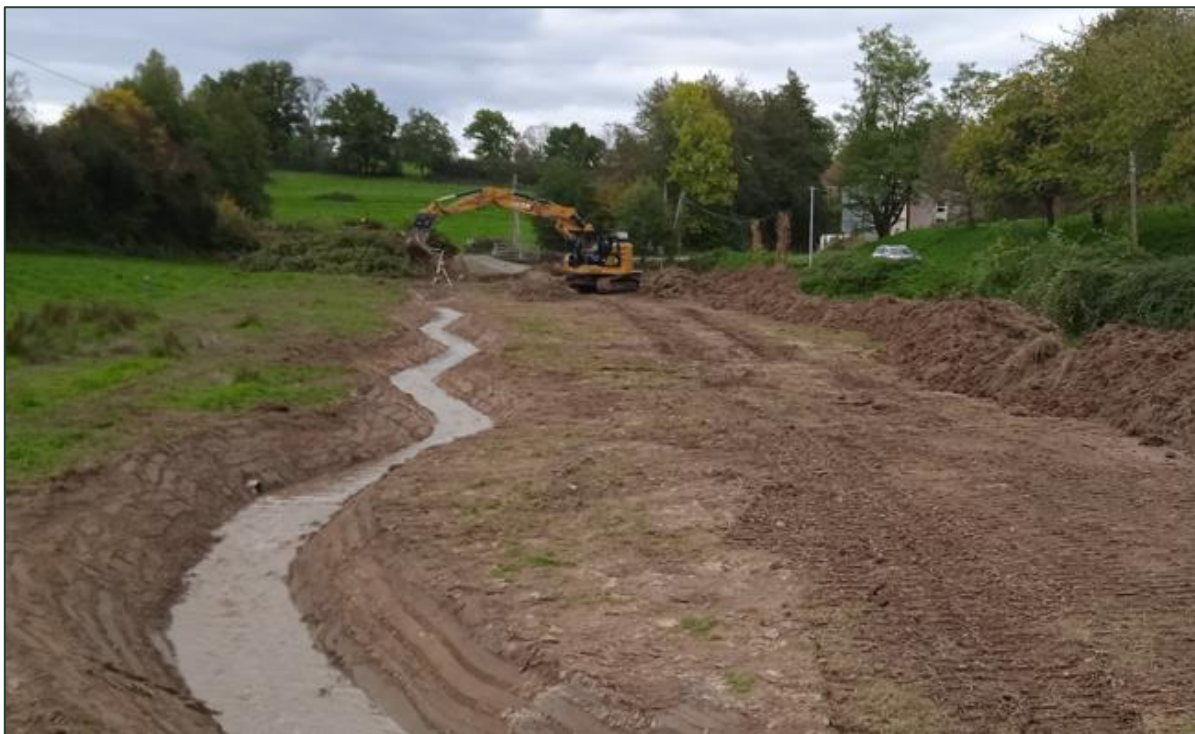
Figure 27. Tracé du lit restauré en fond de vallon pendant travaux et avant recharge alluviale – octobre 2025.
