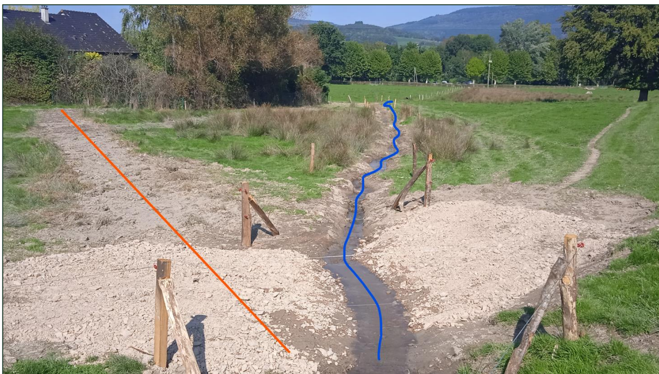
Figure 23. Photo après travaux, en bleu le lit restauré et mis en défens et en rouge l'ancien lit rectifié, comblé.
