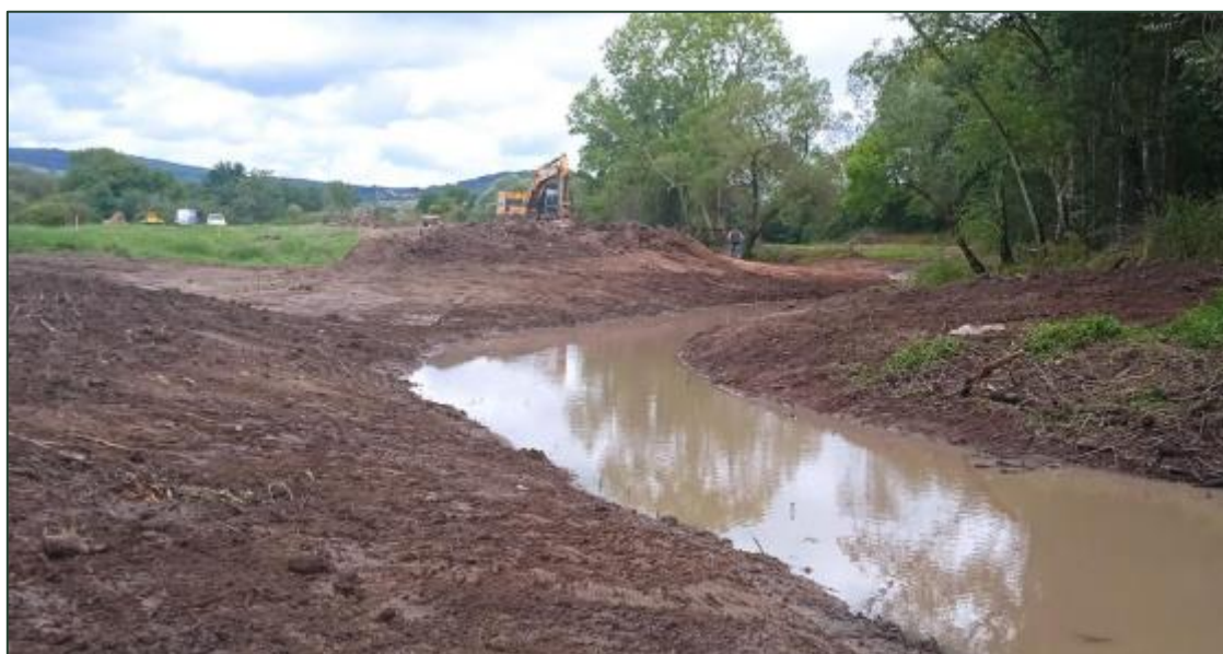
Figure 15. Photo pendant les travaux. A noter qu'un ensemencement pour restaurer la prairie a été réalisé.
