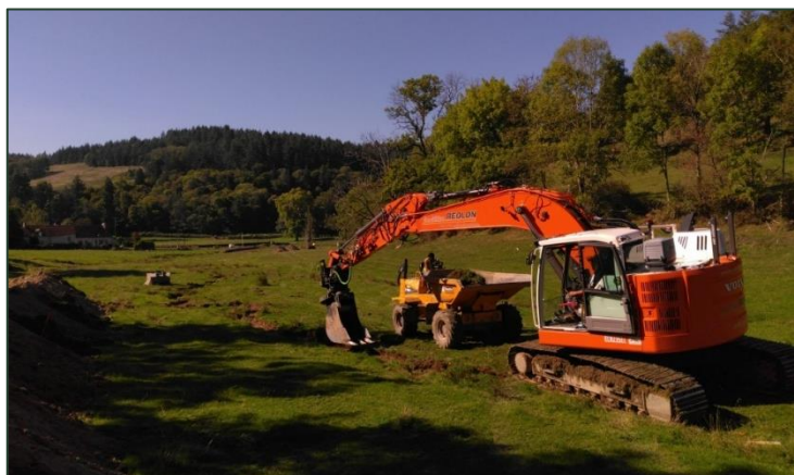
Figure 33. A gauche, le talutage visant à restituer l'écoulement en fond de vallon. A droite, le tronçon protégé par la clôture – septembre 2025.
