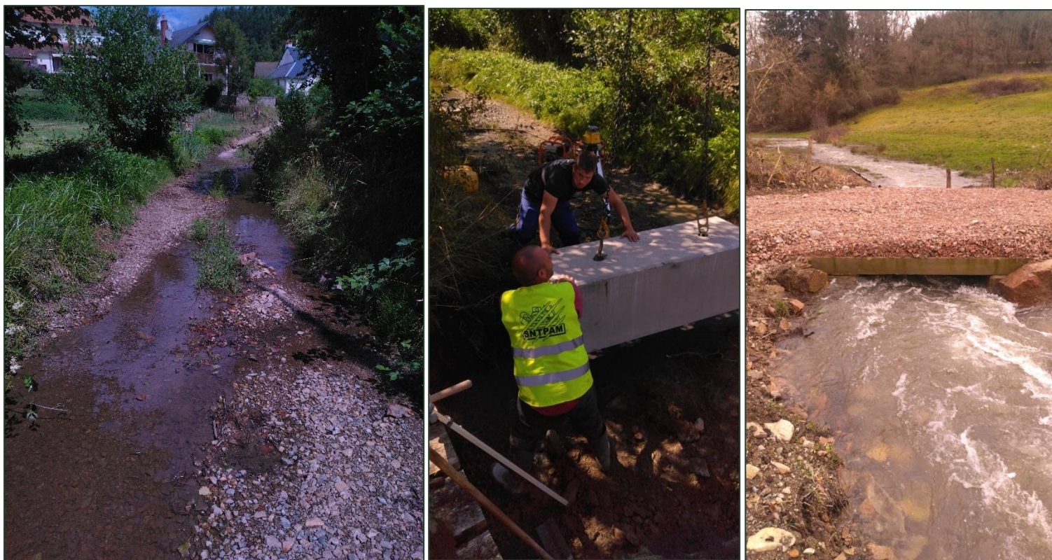
Figure 22. A gauche, photo du tronçon avant travaux. Au centre, installation du ponceau. A droite, le résultat pendant la forte crue de février 2026 avant sécurisation du pont et à l'aval, le tronçon restitué à son emplacement initial.
