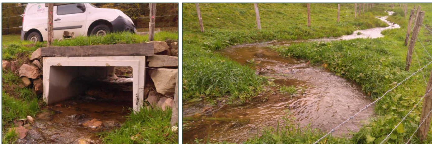
Figure 21. A gauche, photo du ponceau après travaux (octobre 2025) et à droite le cours d'eau restauré dans son fond de vallon et mis en défens (octobre 2025).
