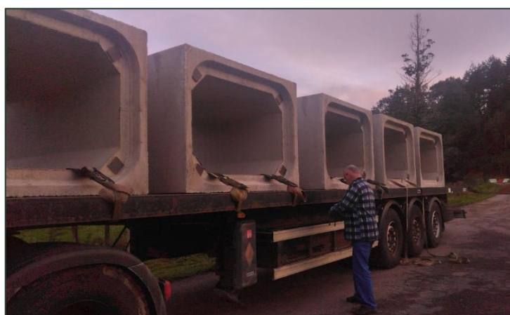
Figure 35. A gauche, l'arrivée des ponceaux. A droite, le ponceau traversant la route, juste après mise en place et avant l'apport d'alluvions (octobre 2025).
