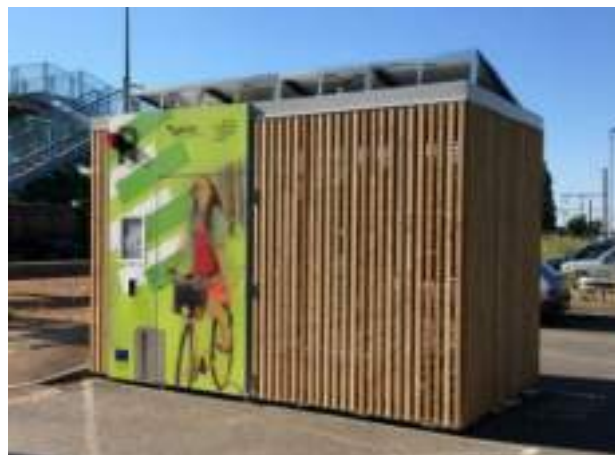
FIGURE 8. PHOTO D'UN ABRIS VELO SECURISE MOBIGO
