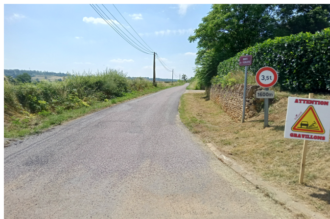
L'un des travaux d'enduit (gravillonnage) réalisés en 2025 à Changy
