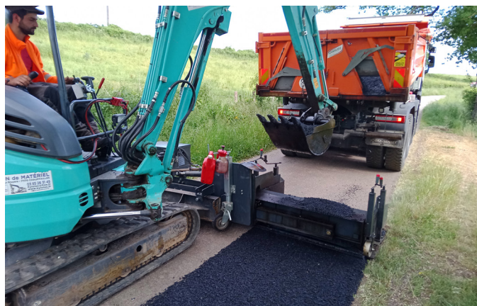
Lors des travaux de voirie réalisés cette année à Champlecy
