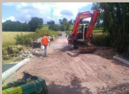
Travaux (59 871,80 € HT subvention 30%)
